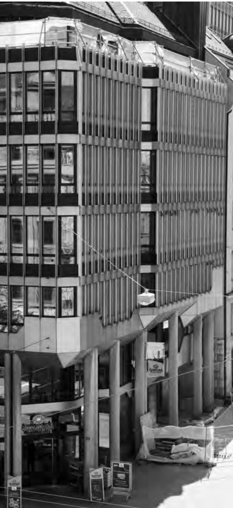
Bank von Architekt Heini Graf, erbaut 1972 bis 1977. (Bild: hrt)
