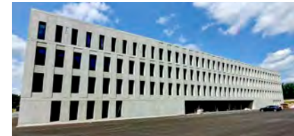
Die neue Kaserne im Auenfeld im Bau.
